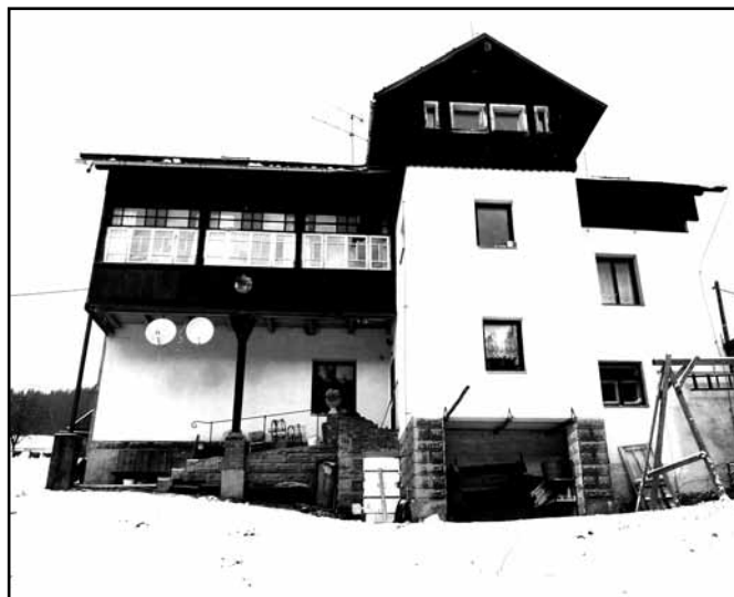
Dnešní vzhled zadní části domu čp. 56 ve Františkově, kde před 80 lety sídlila česká měšťanská škola (foto O. Vašata)
